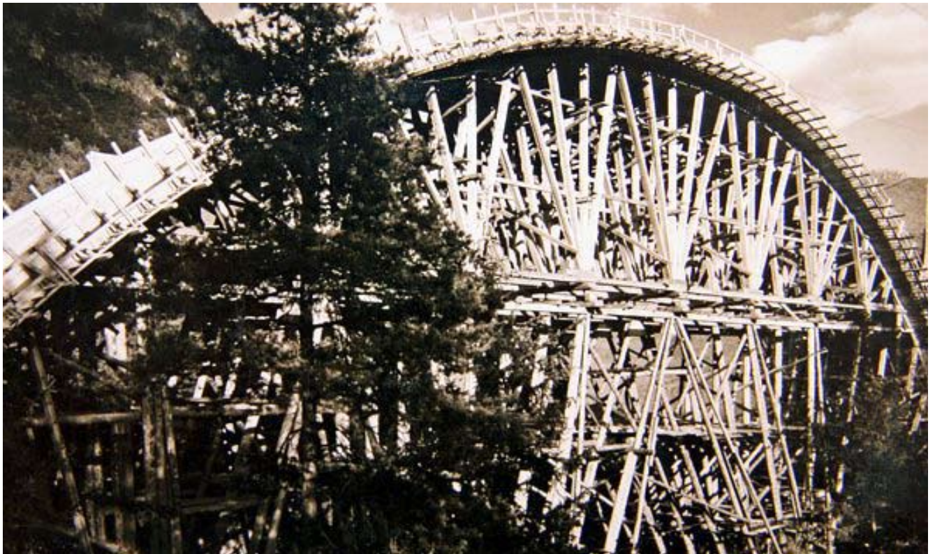
Bild: Bau der Bogenbrücke über den Starkenbach, Bildnachweis: Foto Plangger, Landeck
