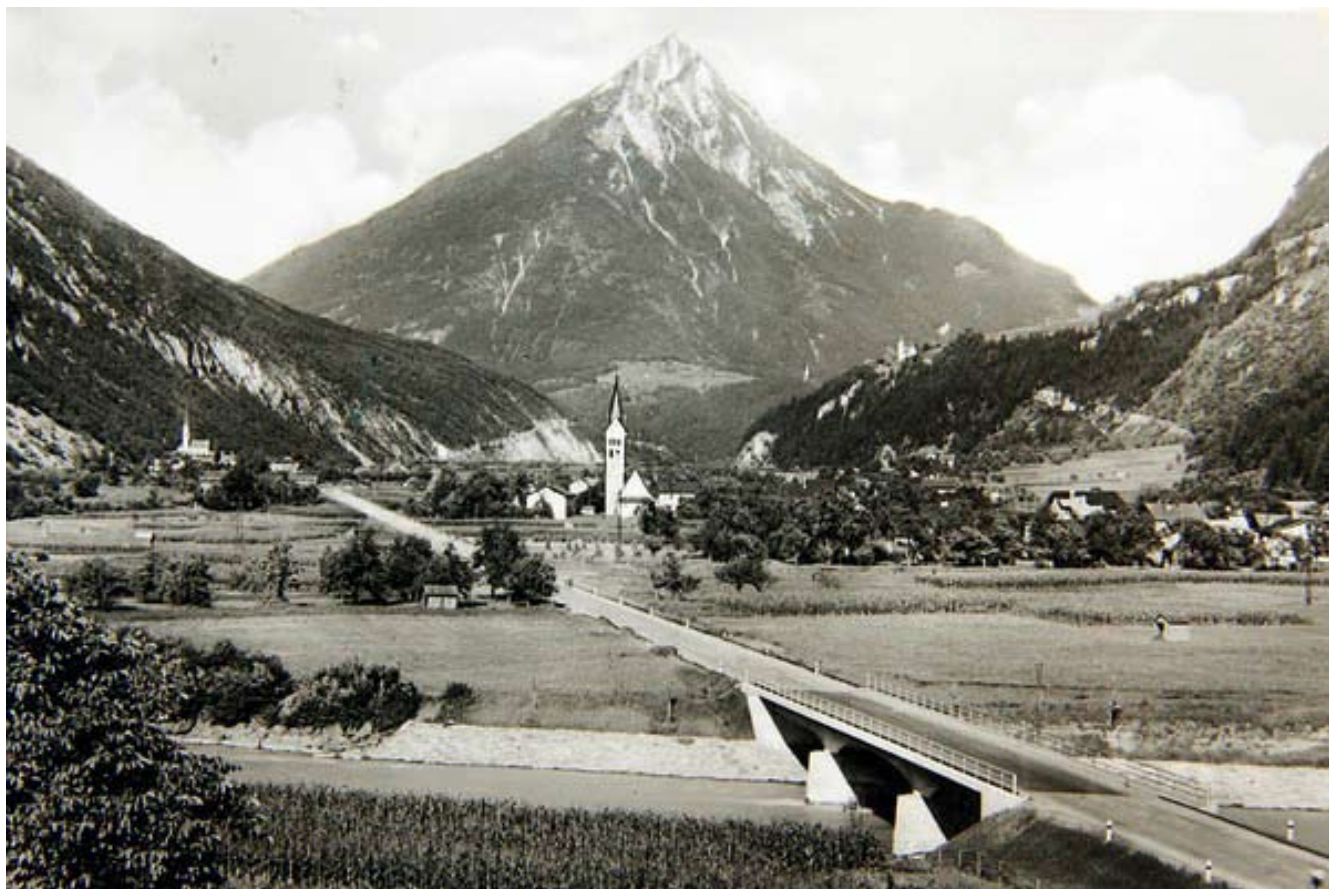
Bild: Fertiggestelltes Straßenstück mit Innbrücke im Bereich Schönwies-Starkenbach
